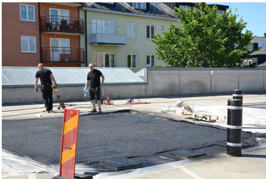
Figur 2.8 Provrutan och provplattorna med Purtop 1000 är klara (Foto: Y Edwards)
