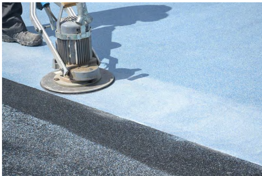
Figur 2.14 Topplacken slipas avslutningsvis (Foto: Y Edwards)
