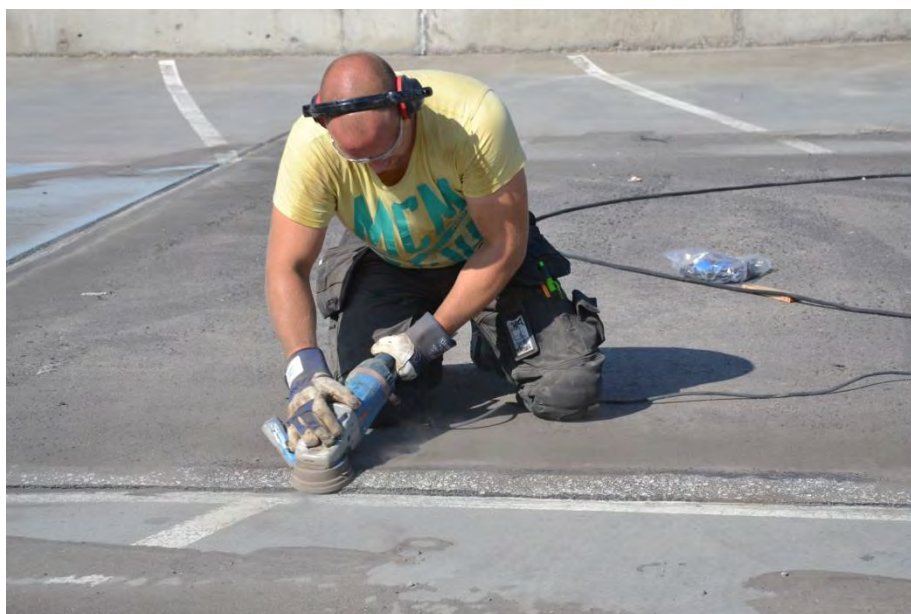
Figur 2.19 Gjutasfaltens kanter slipas ner (Foto: Y Edwards)
