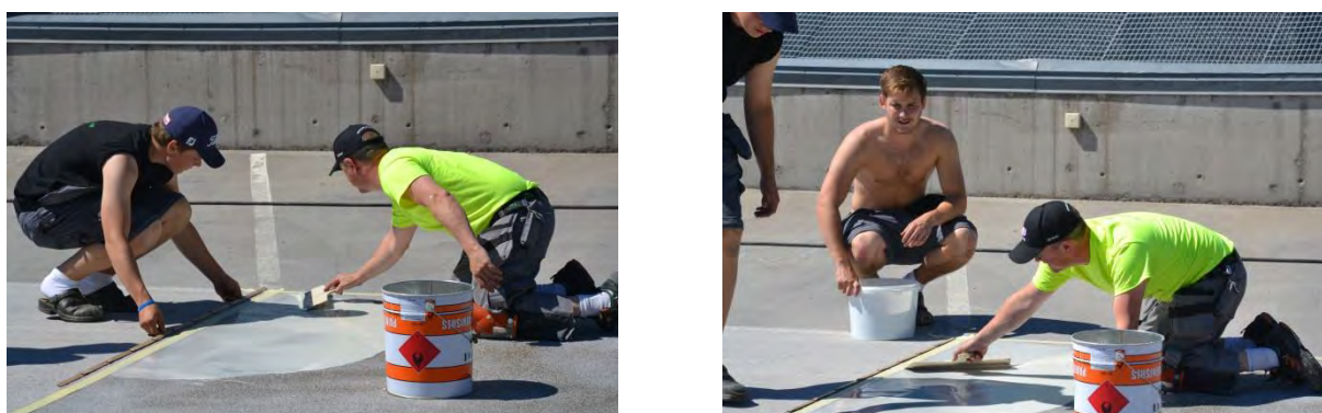
Figur 2.32 Membranet läggs på (Foto: Y Edwards)
