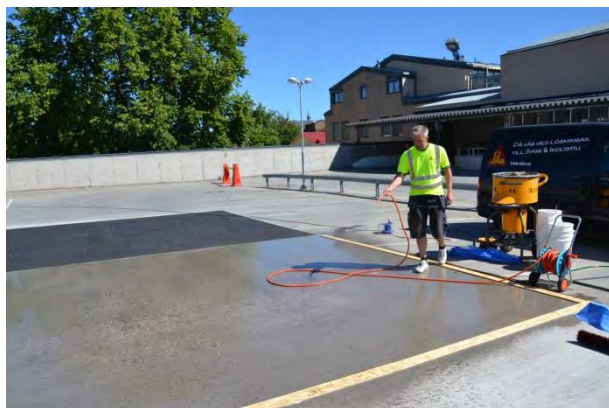
Figur 2.27 Betongen fuktas och primerslamman påföres (Foto: Y Edwards)
