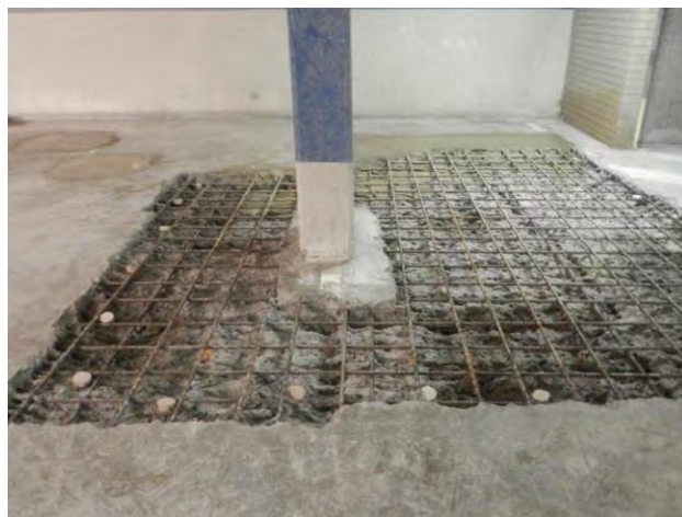
Figur 4.6 Installation av offeranoder av zink med aktivt cementbaserat hölje
