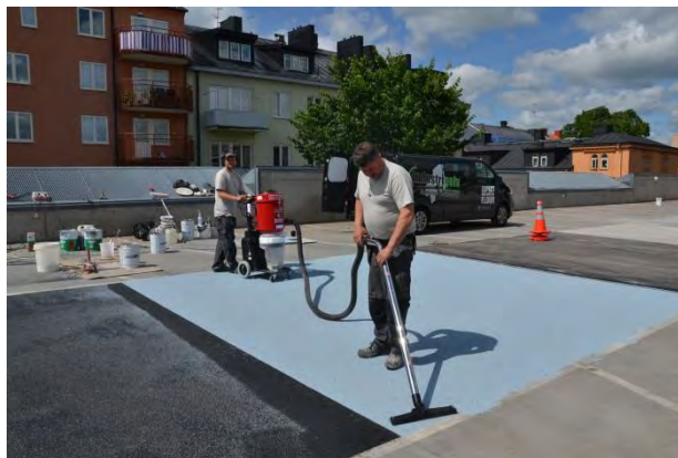
Figur 2.13 Dammsugning (t v) och topplacken påförs (t h) (Foto: Y Edwards)
