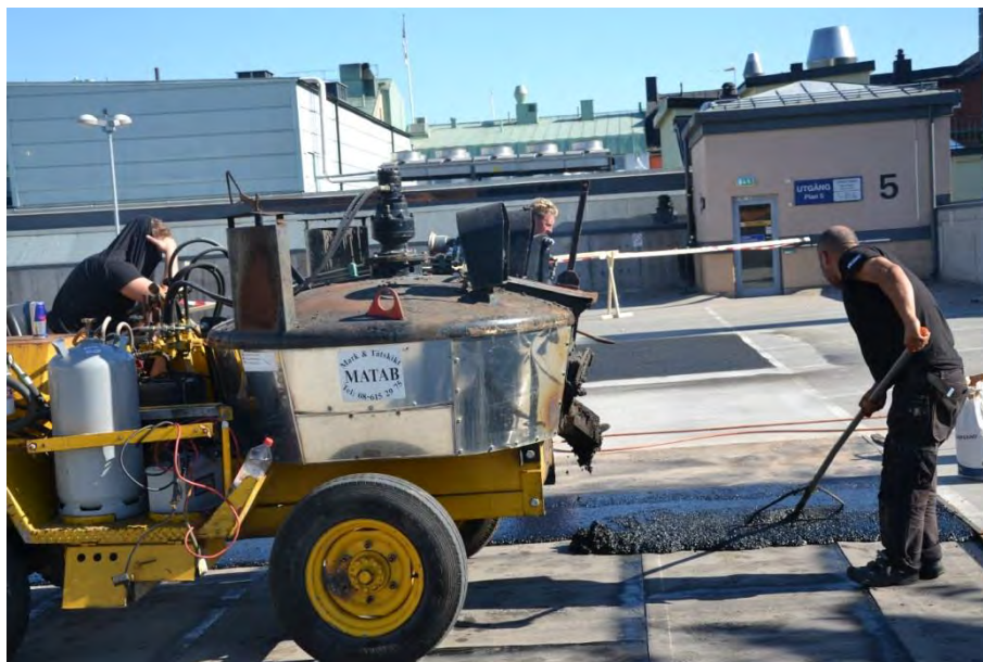
Figur 2.17 Gjutafalten läggs ut (Foto: Y Edwards)
