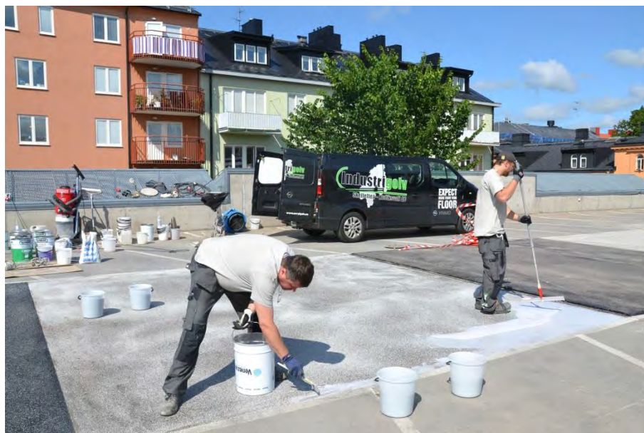
Figur 2.11 Utläggningen av Silikalbeläggningen påbörjas (Foto: Y Edwards)
