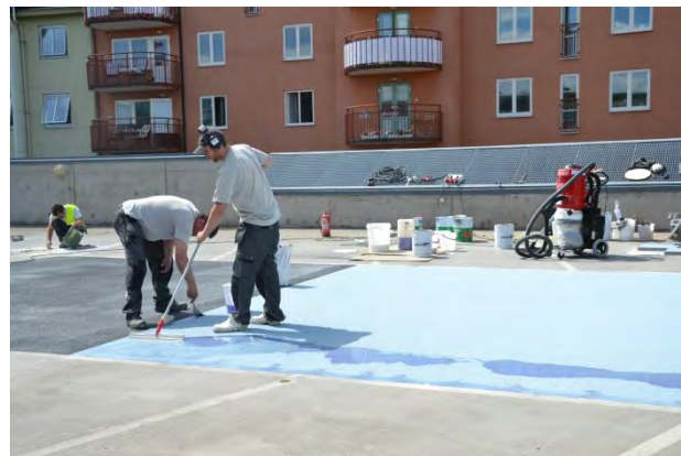
Figur 2.13 Dammsugning (t v) och topplacken påförs (t h) (Foto: Y Edwards)
