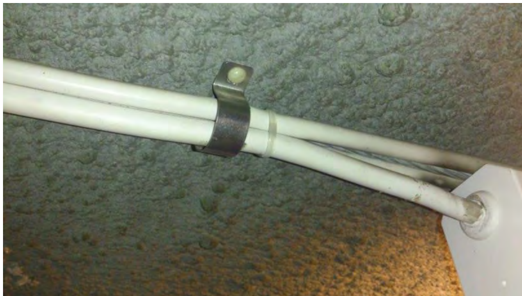
Figur 3.5 Fästelement till bygel monterad i sprutbetong med titannät och armering.
