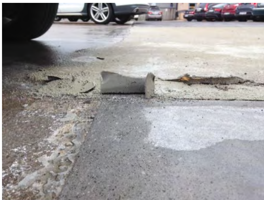
Figur 2.26 Vidhäftningsläpp och snubbelkant (Foto: M Wallin)
