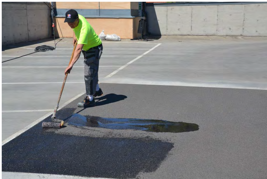
Figur 2.34 Topplack rollas avslutningsvis på (Foto: Y Edwards)
