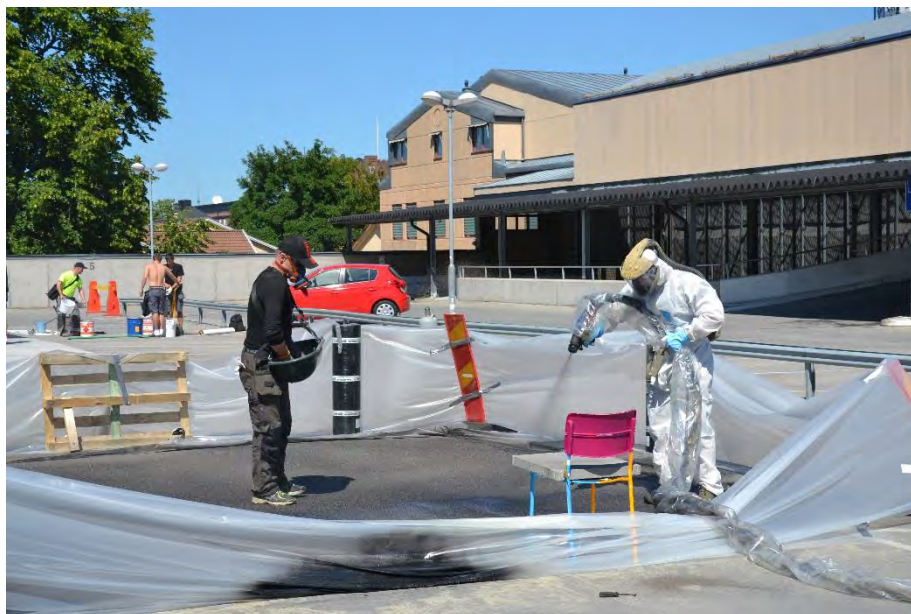
Figur 2.7 Sprutapplicering av Purtop 1000 och bauxit ströas på (Foto: Y Edwards)
