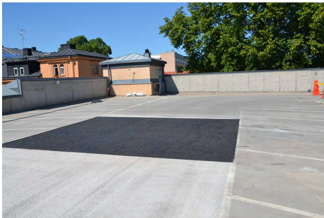
Figur 2.36 Färdig Duracon-beläggning på Baggen (Foto: Y Edwards)
