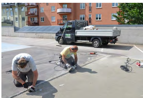
Figur 2.20 Kanten mot Elmicos polyurea krävde lite extra arbetsinsatser (Foto: Y Edwards)
