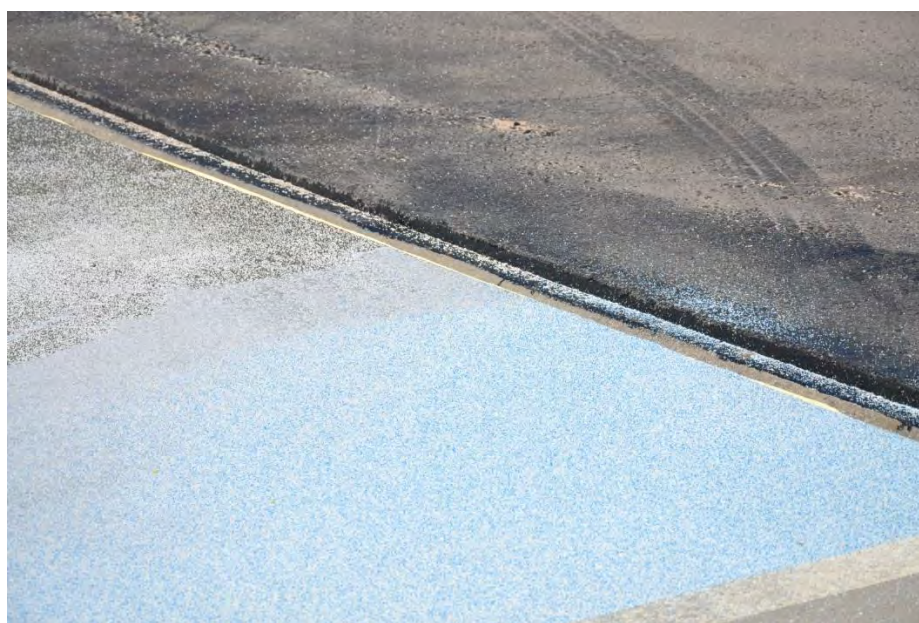
Figur 2.12 Silikalbeläggningen ströas efter hand (Foto: Y Edwards)
