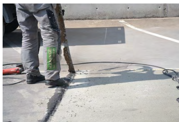
Figur 2.20 Kanten mot Elmicos polyurea krävde lite extra arbetsinsatser (Foto: Y Edwards)
