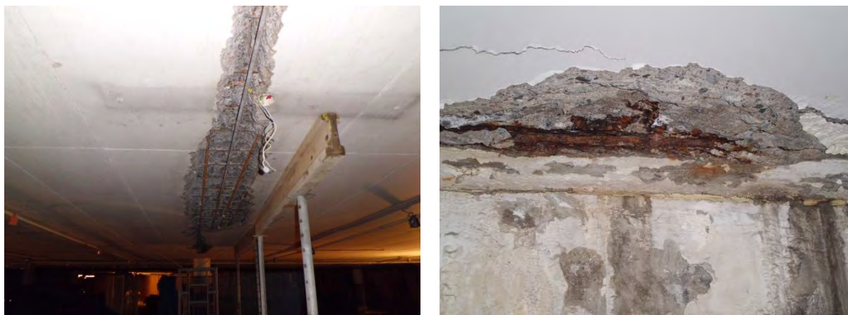
Figur 3.6 Delaminerad betong på grund av kraftiga korrosionsangrepp på armering i golv/tak i parkeringsgaraget under Skrapan i Västerås.
