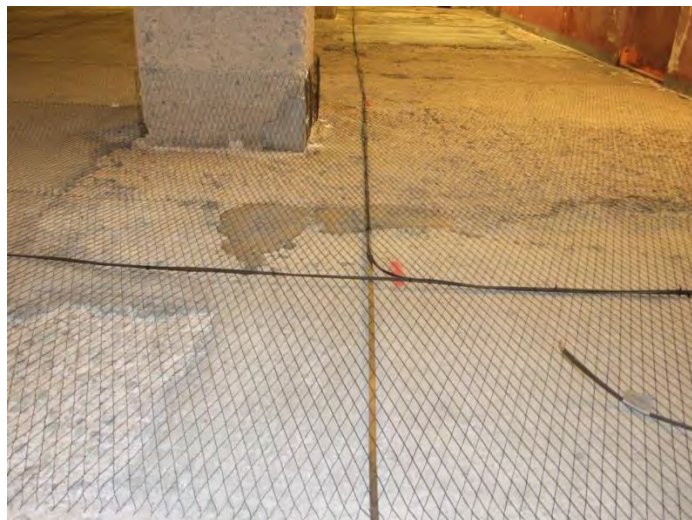
Figur 3.1 Montering av anodnät av titan på betonggolv och nedre del av pelare i parkeringsgaraget Blasieholmen 24
