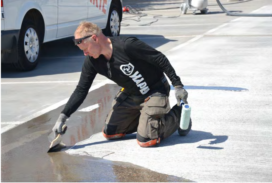
Figur 2.5 Primerbehandling med epoxiprimer (Mapeprimer M) (Foto: Y Edwards)
