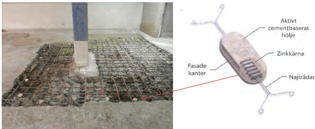
Figur 3.7 Frambilad armering med offeranoder av zink (Galvashield XP) med ett aktivt cementshölje innehållande litiumhydroxid
