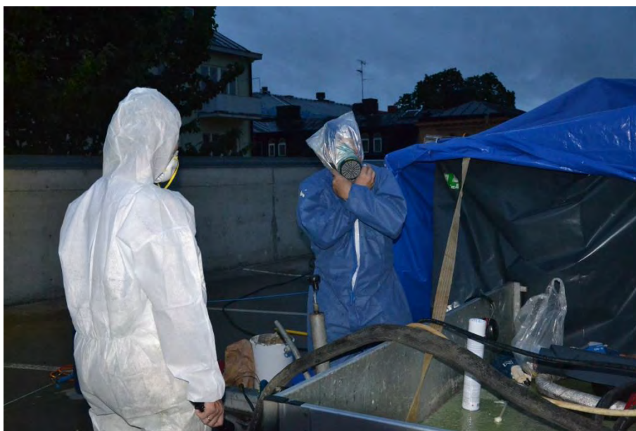
Figur 2.24 När sprutappliceringsarbetet inleddes hade det redan hunnit bli mörkt (Foto: Y Edwards)
