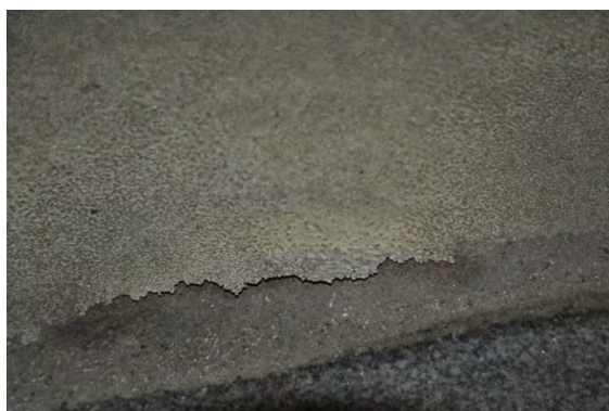
Figur 2.37 Vidhäftningssläpp (t v) och gropar (t h) på yta 8 (Foto: Y Edwards)
