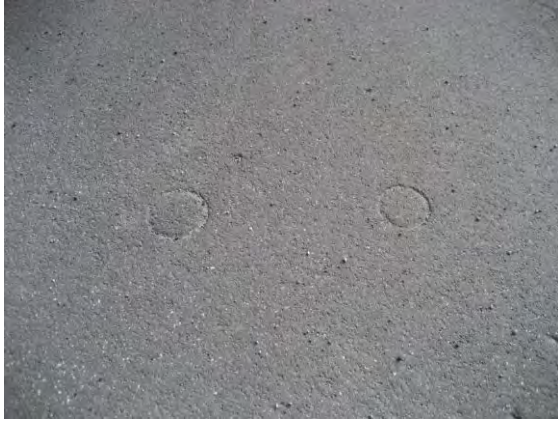
Figur 1.2 Exempel på skador för gjutasfalt (t v) respektive hårdplast (t h) [3]
