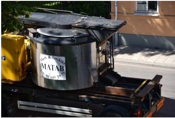
Figur 2.16 Gjutafalten anländer till Baggen (t v) och transporteras upp till plan 5 i omgångar (t h) (Foto: Y Edwards)
