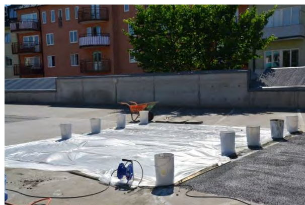
Figur 2.30 Membranhärdare sprutas på och provytan täcks med plast (Foto: Y Edwards)
