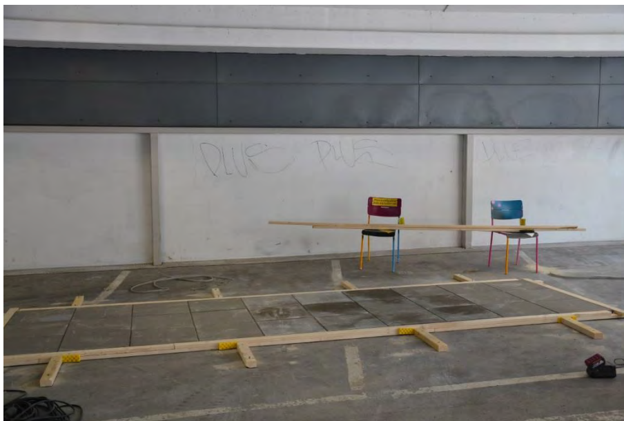
Figur 2.4 Betongplattorna ramas in inför behandlingen med scanmaskin (Foto: Y Edwards)
