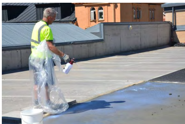
Figur 2.30 Membranhärdare sprutas på och provytan täcks med plast (Foto: Y Edwards)
