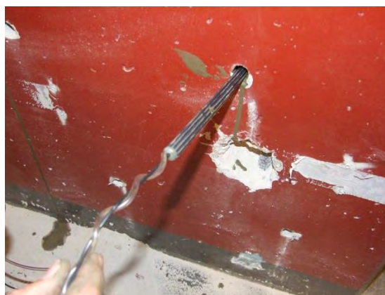
Figur 4.4 Provinstallation av insticksanoder i två pelare i parkeringshus på Blasieholmen. Montering av instickselektrod i pelare
