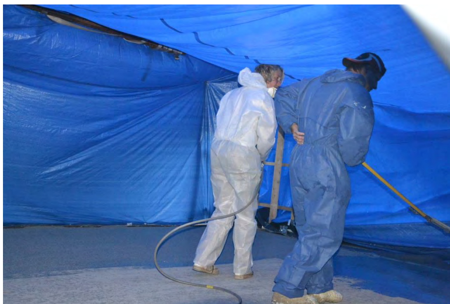
Figur 2.22 Primern påförs och ströas (Foto: Y Edwards)
