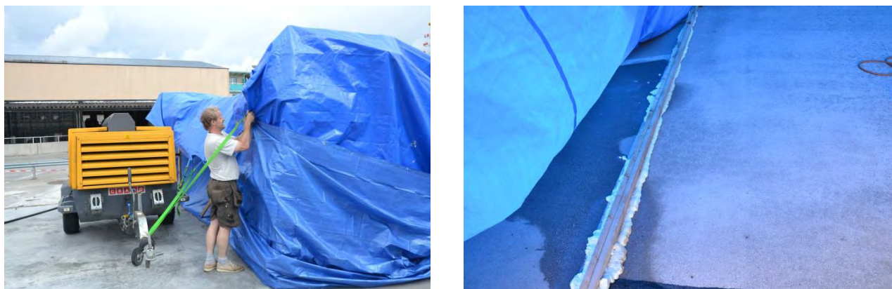
Figur 2.21 Vädskyddet tar form och vattnet måste hållas utanför provytan (Foto: Y Edwards)
