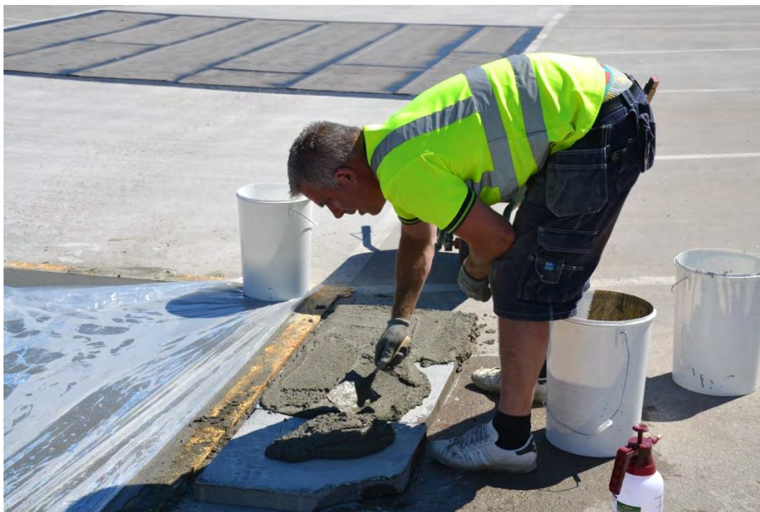
Figur 2.31 Provp Plattorna appliceras (Foto: Y Edwards)
